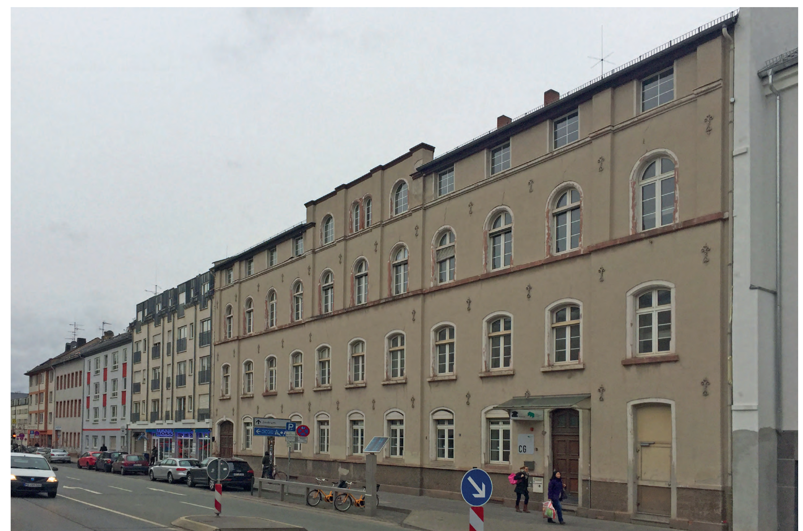
Abb. 2: Ehemaliges Caritas-Gebäude an der Holzhofstraße
